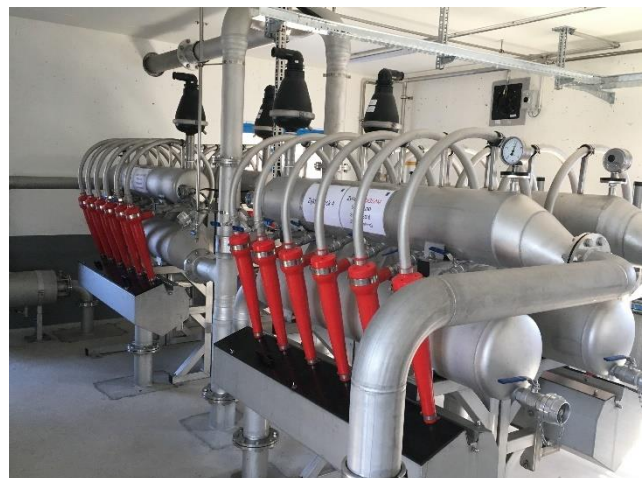
Billede af den nye Selector på Glarnerland Renseanlæg 2019)
